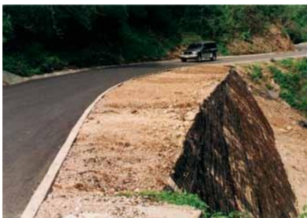
Fuente: catálogo PAVCO, Estabilización con geomalla Uniaxial
